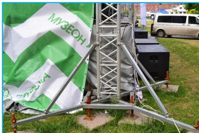
Подъемная система предназначена для установки и подъема быстровозводимых сценических конструкций из ферм, для проведения масштабных мероприятий.
