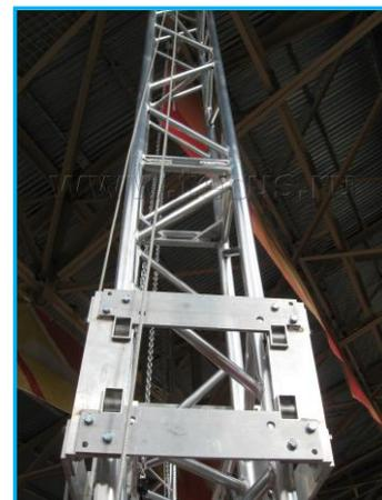
Тип соединения ферм опорной стойки и ферм периметра конструкции может быть либо коннекторный, либо фланцевый (болтовой).
